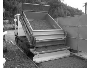
写真-1 POC 敷均し機
