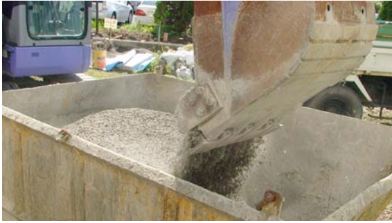
写真-4 POCの練混ぜの様子
