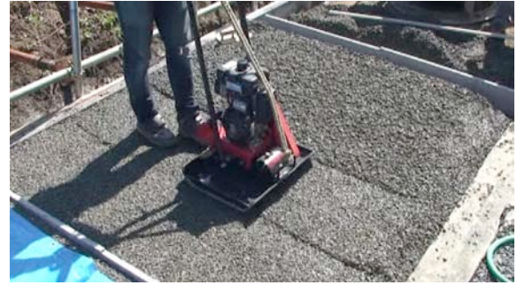
写真-6 POC仕上げ機(M3)による締固めの様子
