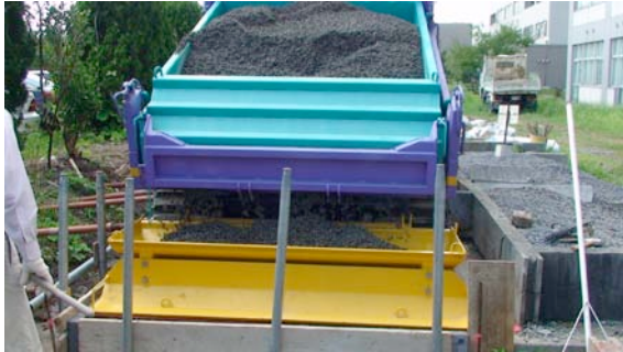
写真-5 POC敷均し機による敷均しの様子
