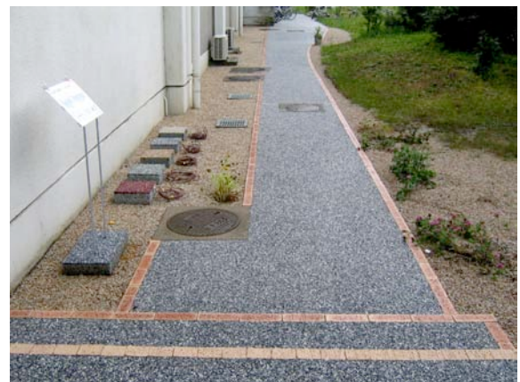
写真-1 POC を用いた透水性舗装の施工例 1)
