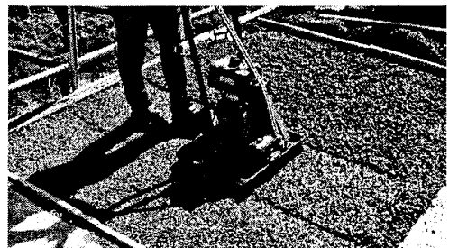
写真-4 仕上げ機を用いた POC の仕上げ
