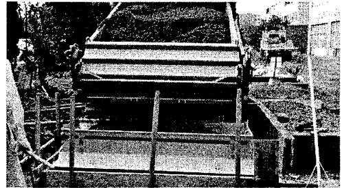
写真-3 敷均し機を用いた POC の敷均し
