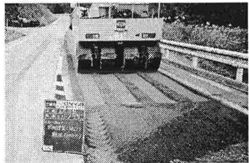
図2 路盤施工状況
