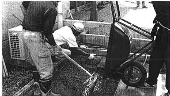
写真4 ポーラスコンクリートの打設 (C区画)
