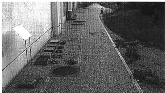
写真6 複層ポーラスコンクリート歩道施工後の状況 (D1、D2、D3区画)
