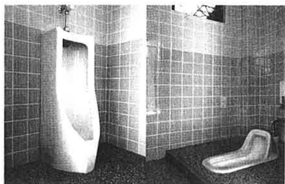
写真10 トイレの施工例
