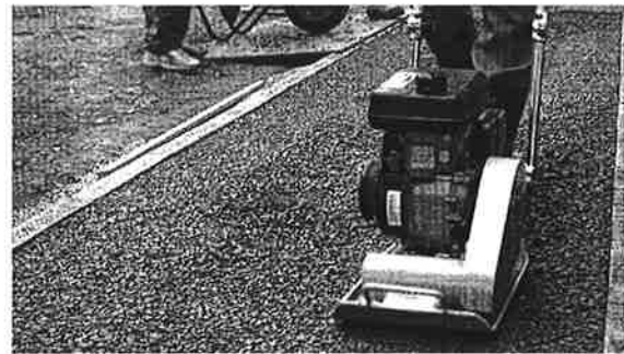
写真5 振動締め機による締め (B区画)
