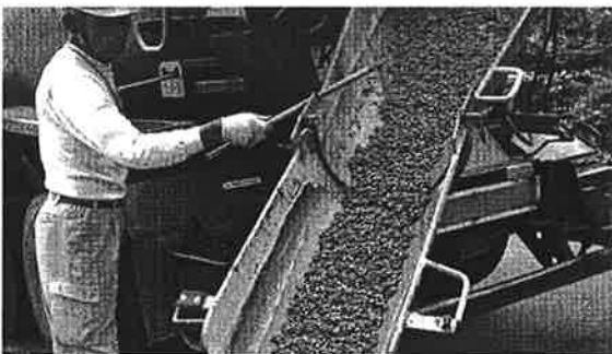
写真3 アジテータ車からのポーラスコンクリートの排出状況
