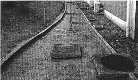
写真2 路床のセメント被膜、縁石設置状況 (D3区画)
