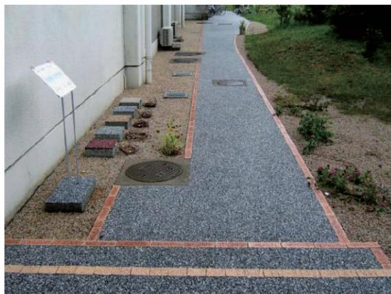
写真-1 ポーラスコンクリートを用いた歩道<sup>2)</sup>
