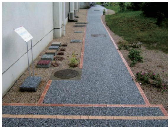
写真-1 ポーラスコンクリートを用いた歩道 2)
