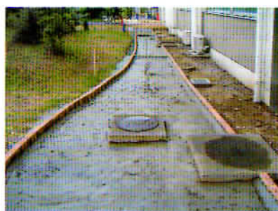
写真-5 路床のセメント被膜、縁石設置状況 (D3区画)
