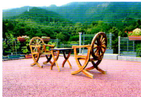
写真-13 住宅の屋上における施工例
