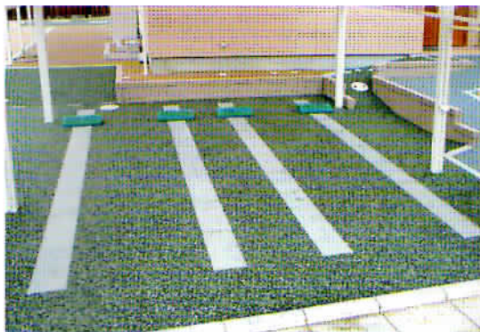
写真-10 駐車場における施工例
