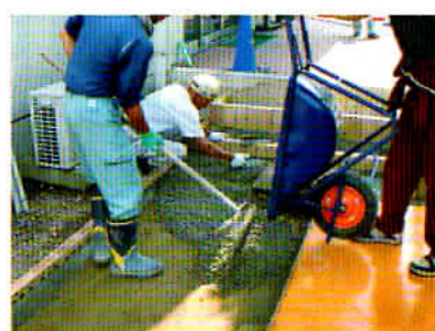
写真-7 ポーラスコンクリートの打設 (C区画)
