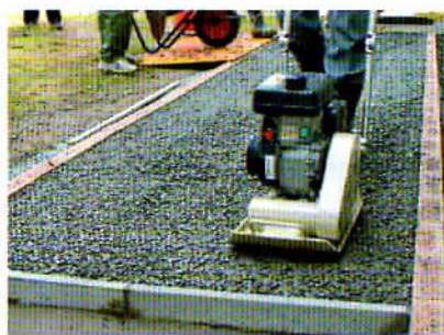
写真-8 振動締め機による基層の締め固め (B区画)
