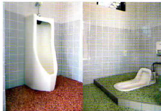
写真-12 トイレにおける施工例
