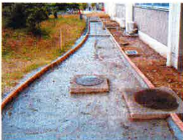
写真-5 路床のセメント被膜，縁石設置状況 (D3区画)
