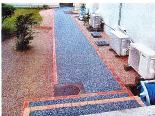
写真-3 複層ポーラスコンクリート歩道施工後の状況 (A, B, C区画)
