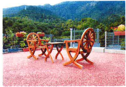
写真-13 住宅の屋上における施工例
