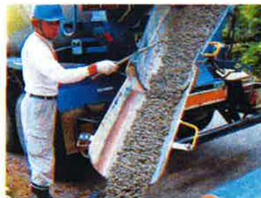
写真-6 アジテータ車からのポーラスコンクリートの排出状況
