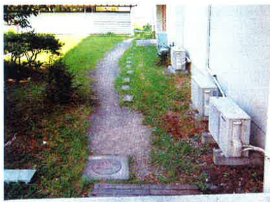
写真-1 施工前の状況 (A, B, C区画該当箇所)
