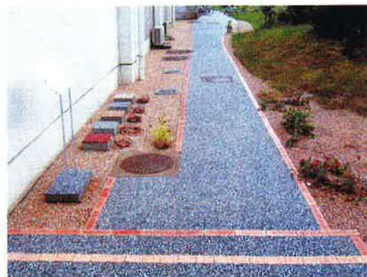
写真-4 複層ポーラスコンクリート歩道施工後の状況 (D1, D2, D3区画)
