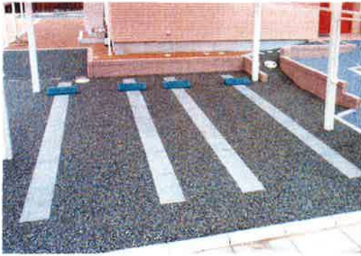
写真-10 駐車場における施工例
