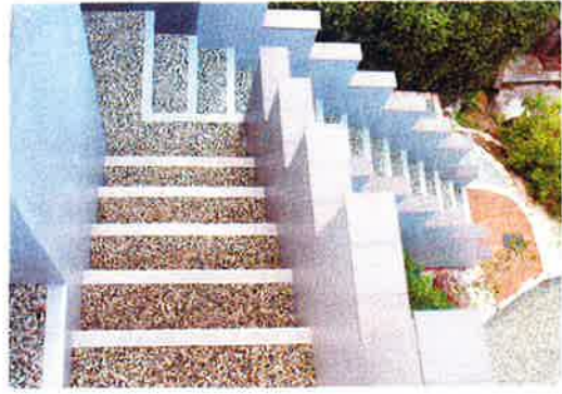
写真-11 屋外階段における施工例
