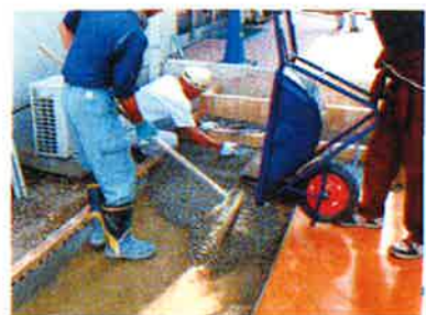
写真-7 ポーラスコンクリートの打設 (C区画)
