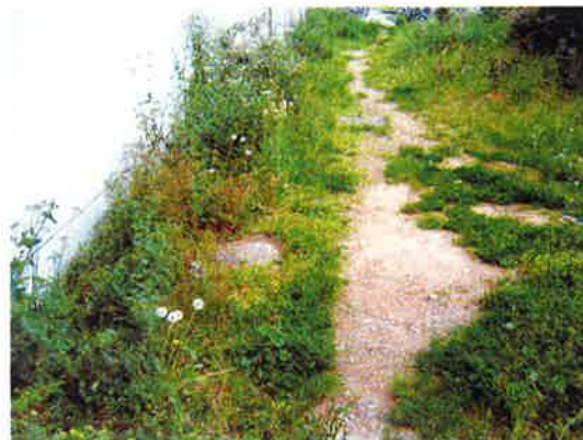
写真-2 施工前の状況 (D1, D2, D3区画該当箇所)
