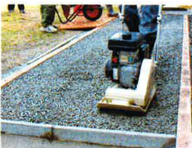
写真-8 振動締固め機による基層の締固め (B区画)
